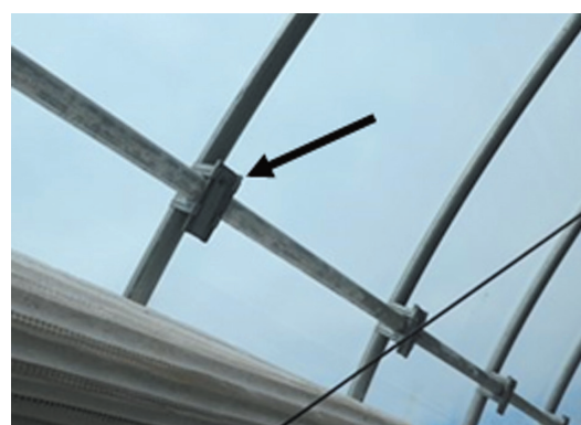
図2 パイプ締結部分
