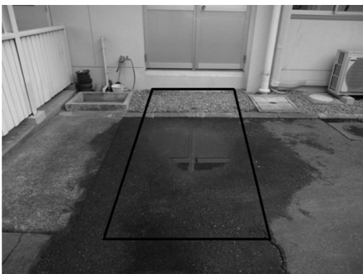
図1 第一施工区画
