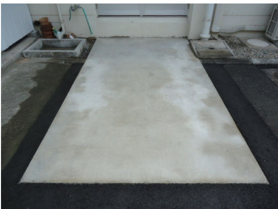
図8 施工後21ヶ月経過後の外観写真
