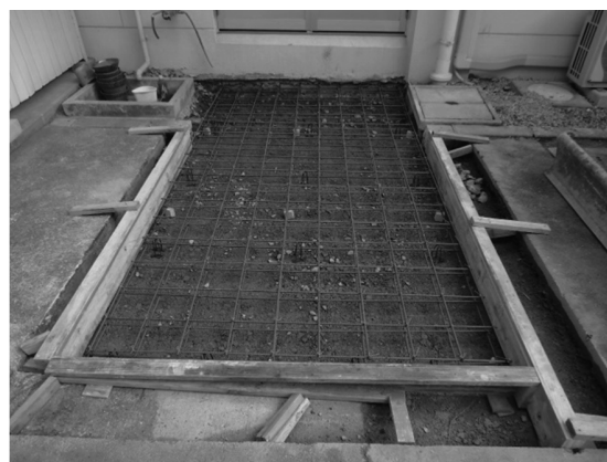
図5 配筋が完了した型枠の外観写真
