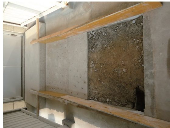
図9 打設前の型枠の外観写真
