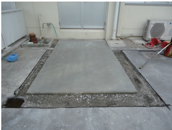
図7 型枠除去後の外観写真
