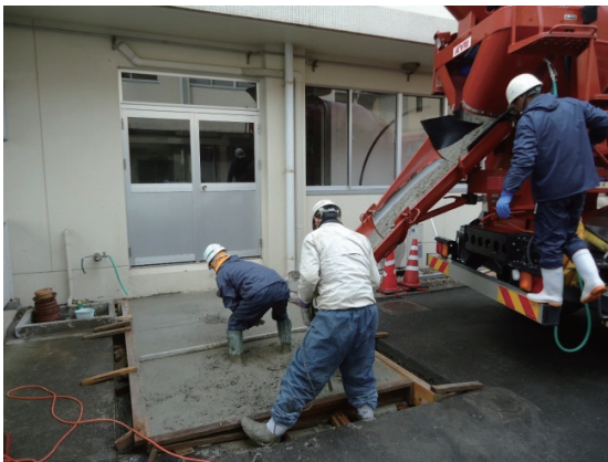
図6 打設作業の様子
