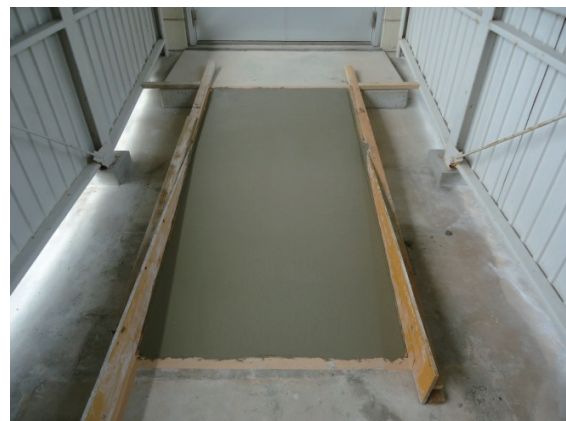
図10 金ごて仕上げ後の外観写真
