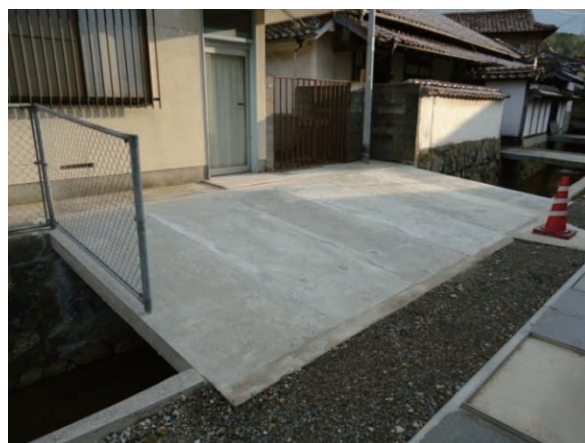
図10 試作した床版の設置後の写真
