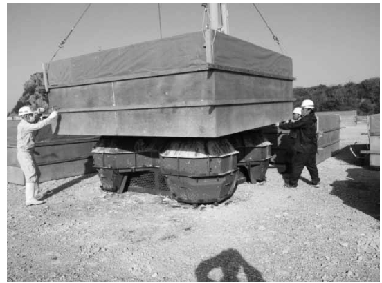
図1 打設後の被覆ブロックに保温箱を被せる様子
