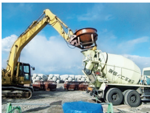
図4 ミキサー車に瓦粉碎物を投入する様子
