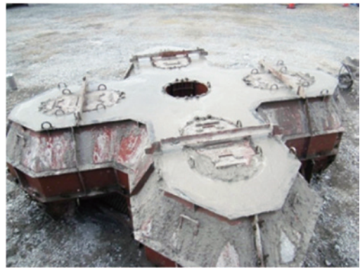
図6 打設完了後の写真
