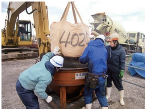
図3 ホッパーに瓦粉碎物を投入する様子
