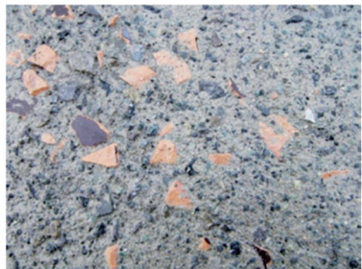
図7 天端部のレイタンス処理後の表面
