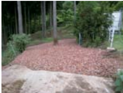
図4 瓦粉砕物敷設直後の様子
