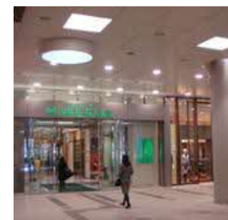
LED照明 (渋谷マークシティ設置)
