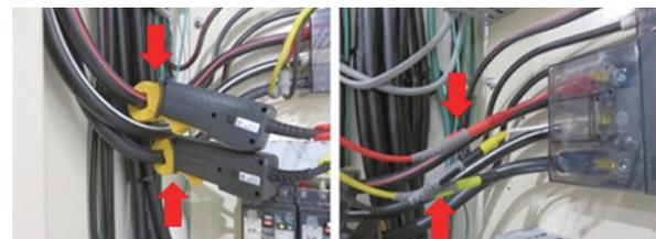
クランプ式電流センサ 電圧ケーブル
